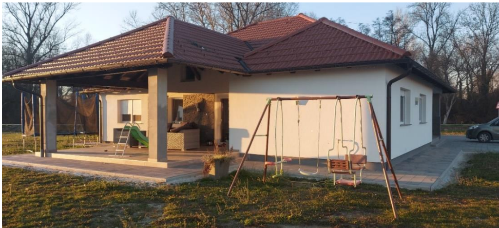
Slika 17. Južna strana kuće (Autor: Bernard Lončarić)
