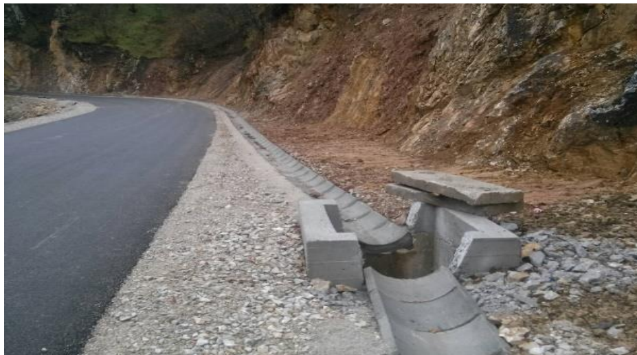
Slika 12. Primjer postavljanja betonskih kanalica uz cestu ( https://visoko.co.ba/na-dionici-puta-kakanj-trsce-ponijeri-postavljanje-betonskih-kanalica-i-sigurnosne-ograde/ )
