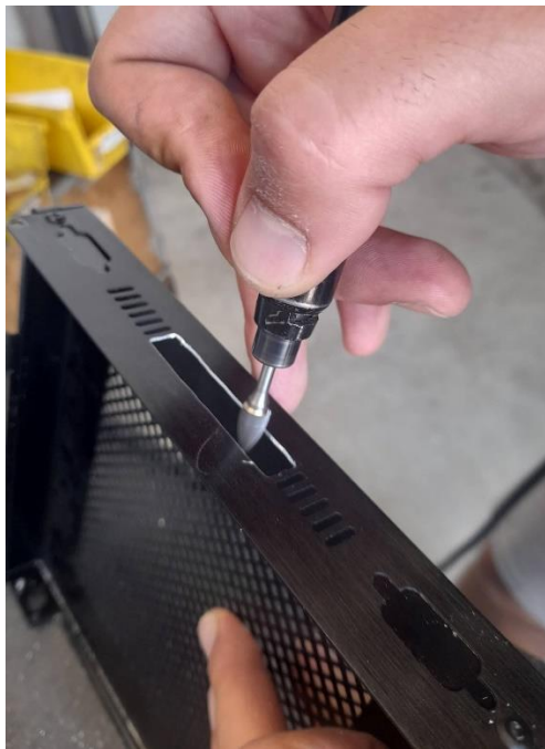
Slika 21. Izrezivanje utora za ugradnju mrežne kartice
