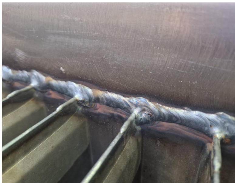
Slika 20. Popravljeni zavar
