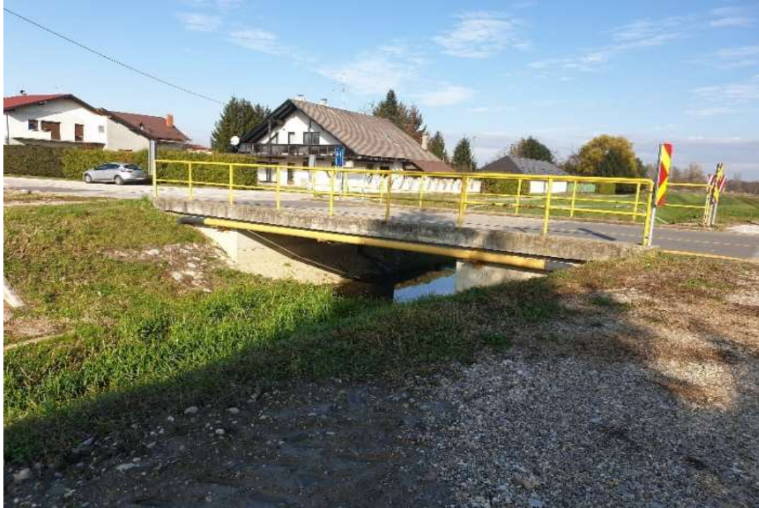
Slika 11. Postojeće stanje mosta – jug
