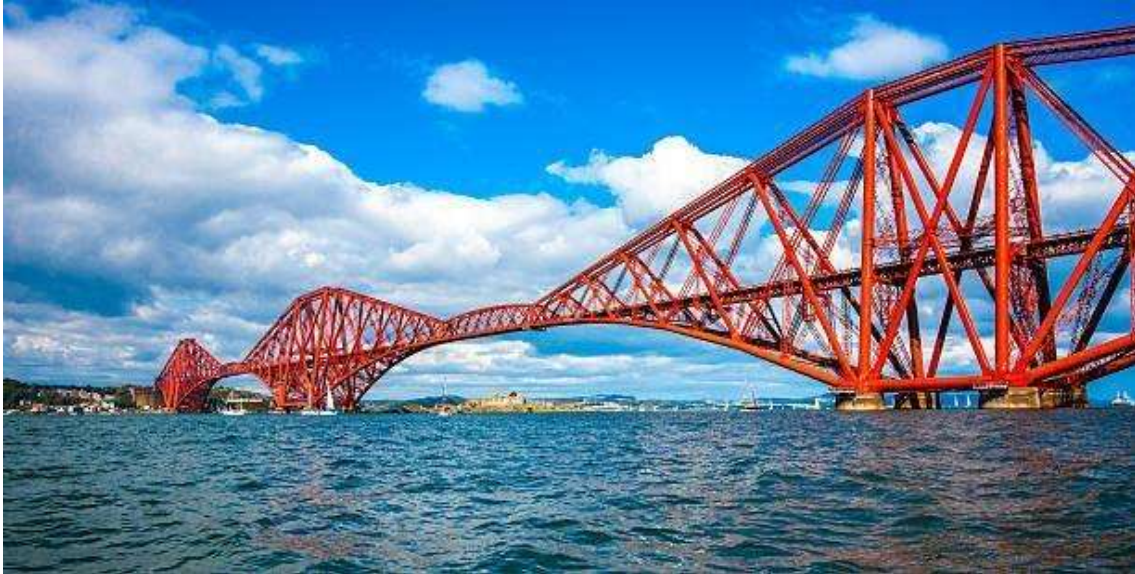
Slika 7. Konzolni most – Forth bridge u Škotskoj
