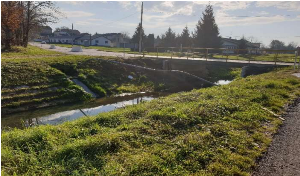
Slika 12. Postojeće stanje mosta – sjever
