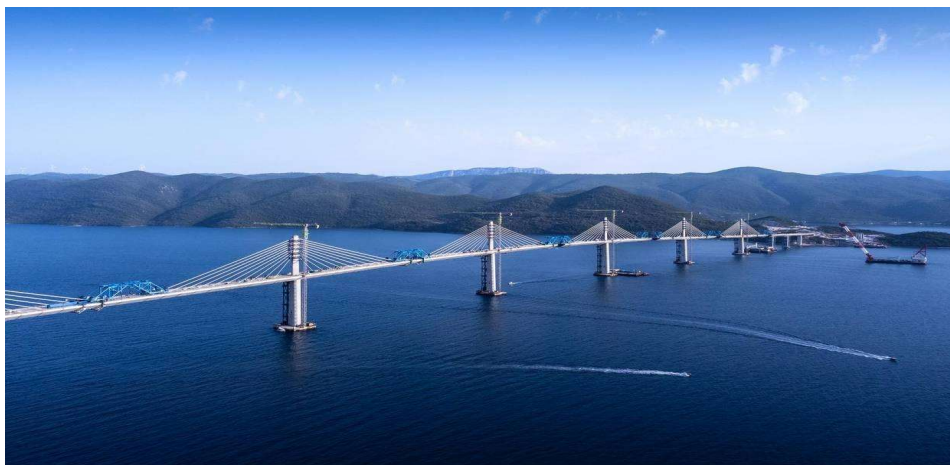
Slika 8. Ovješeni most – Pelješki most
