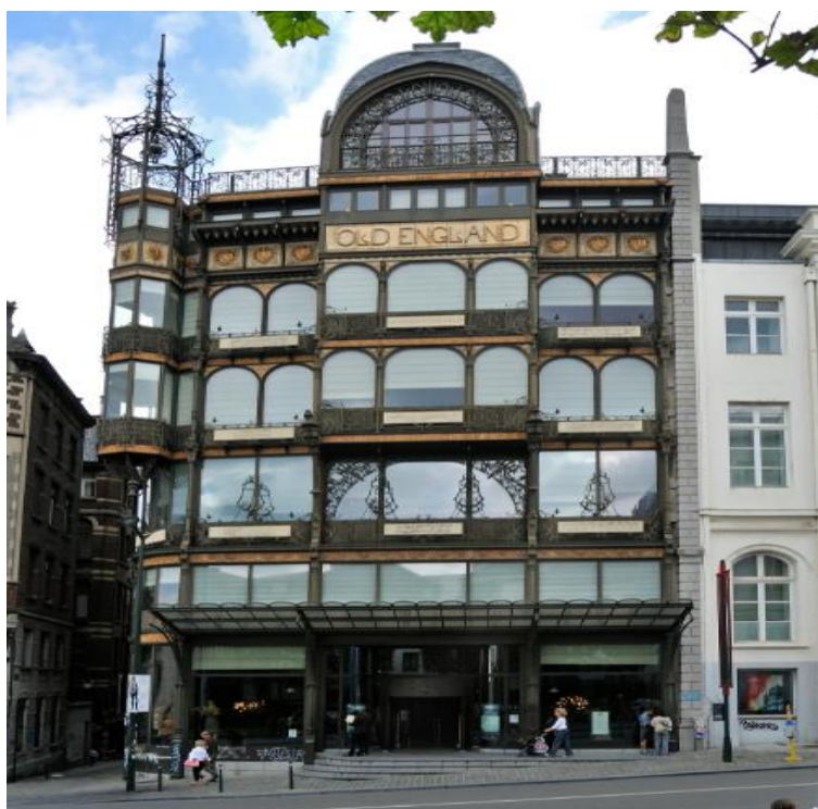
Slika 15. Zgrada inspirirana secesijom, Brussel, Paul Saintenoy
