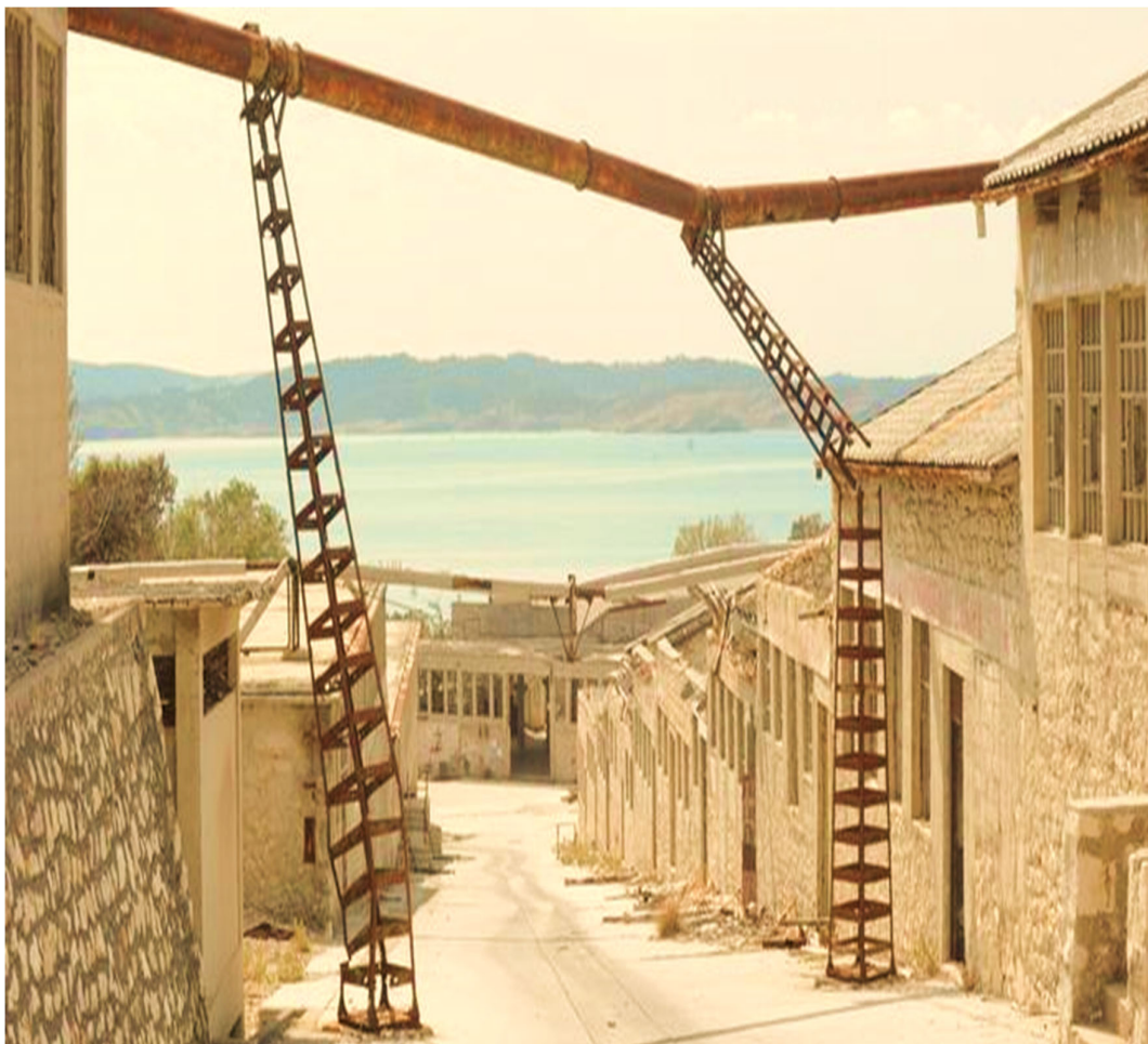
Slika 17. Devastirani objekti na Golom otoku
