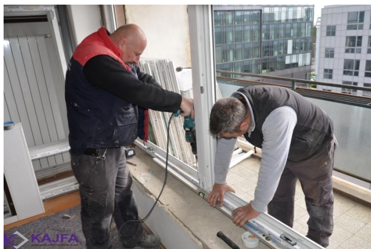
Slika 4. Ugradnja prozora
