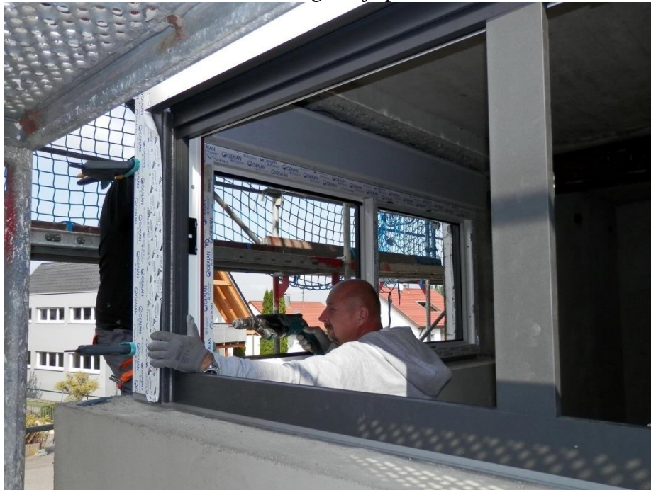
Slika 21. Ugradnja prozora
