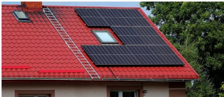
**Slika 41.** Loša uklopljenost boje panela s bojom pokrova
