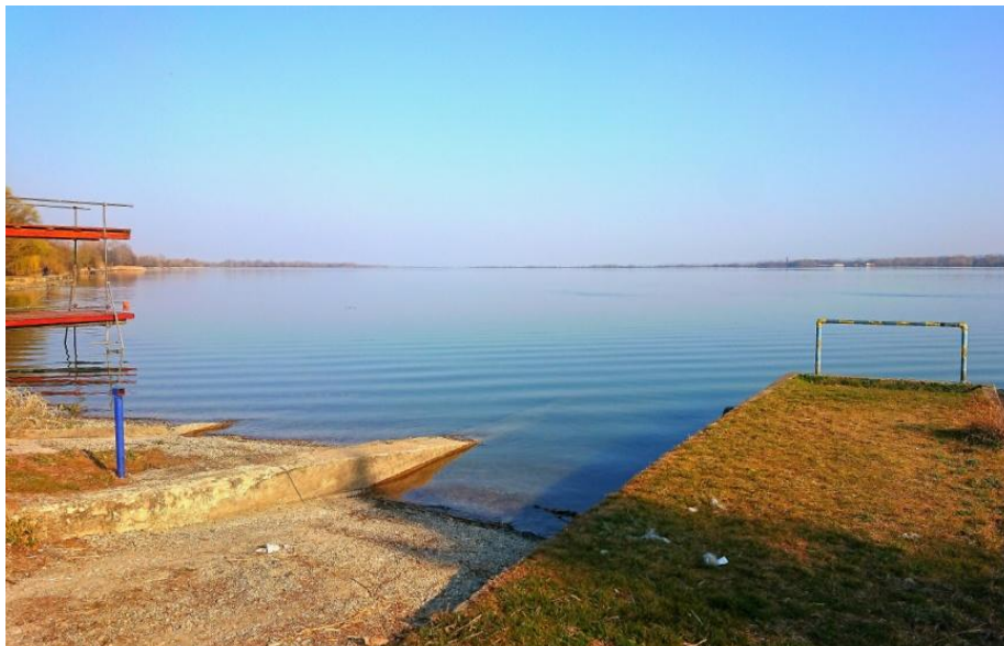
Slika 31. Rampa za čamce na početku jezera HE Čakovec kod Gornjeg Kuršanca
