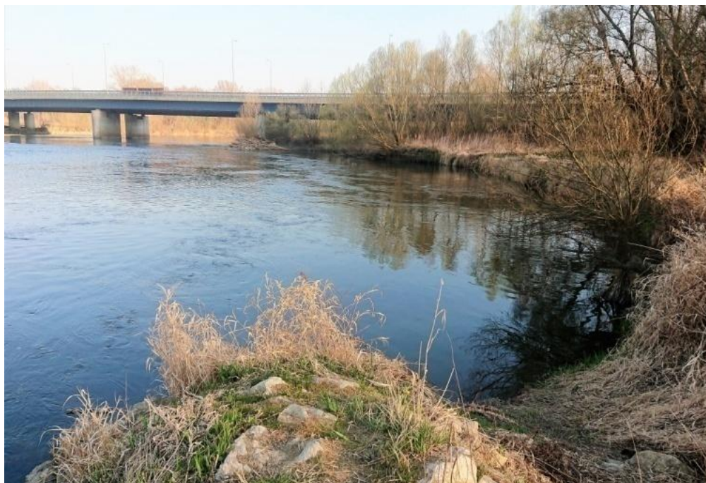
Slika 21. Kameni šporanj i novi most na Muri kod Goričana
