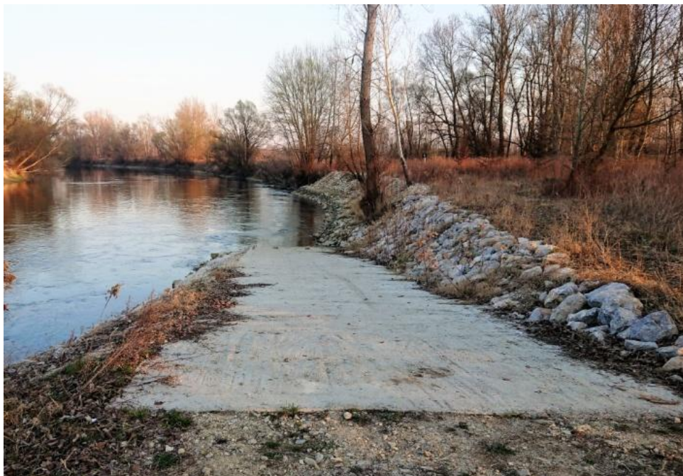
Slika 22. Rampa za plovila kod naselja Kotoriba
