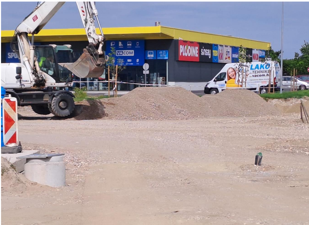
Slika 22. Deponija šljunčanog materijala
