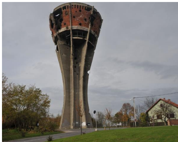
Slika 17. Vukovarski vodotoranj prije obnove
