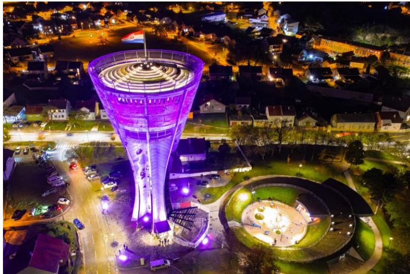
Slika 23. Prikaz obnovljenog Vodotoranja iz zraka
