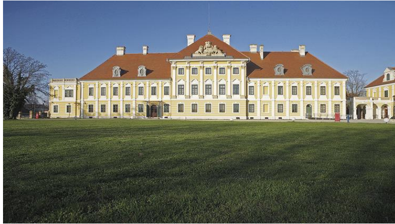
Slika 33. Obnovljen dvorac Eltz
