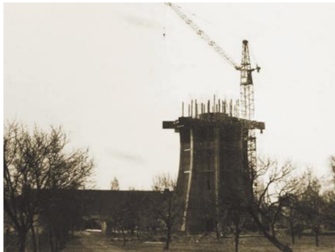
Slika 11. Početak izgradnje novog vodotoranja
