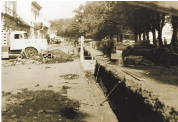
Slika 9. Detalj gradnje vodoopskrbne mreže 1965.
