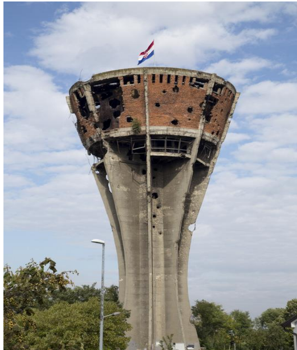
Slika 1. Vukovarski vodotoranj prije obnove
