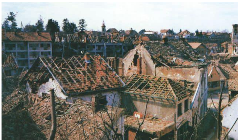
Slika 28. Grad Vukovar u ruševinama tijekom Domovinskog rata
