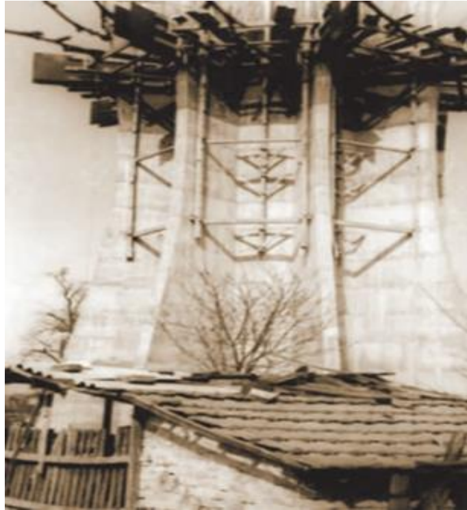
Slika 12. Prikaz skele pomoću koje se odvijala izgradnja
