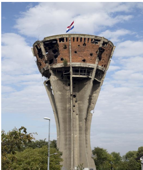
Slika 1. Vukovarski vodotoranj prije obnove
