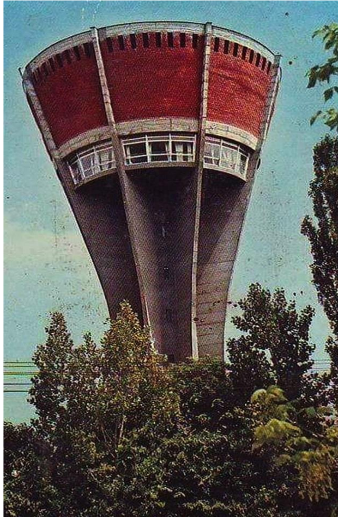
Slika 13. Vukovarski vodotoranj nakon što je izgrađen
