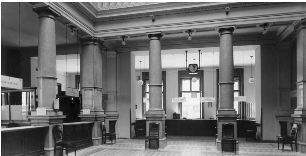
Slika 3 Prva hrvatska štedionica - unutrašnjost
