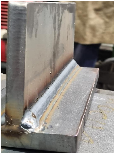
Slika 20. Zavareni kutni zavar sa 3 prolaza
