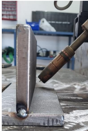
Slika 25. Priprema za kutni zavar
