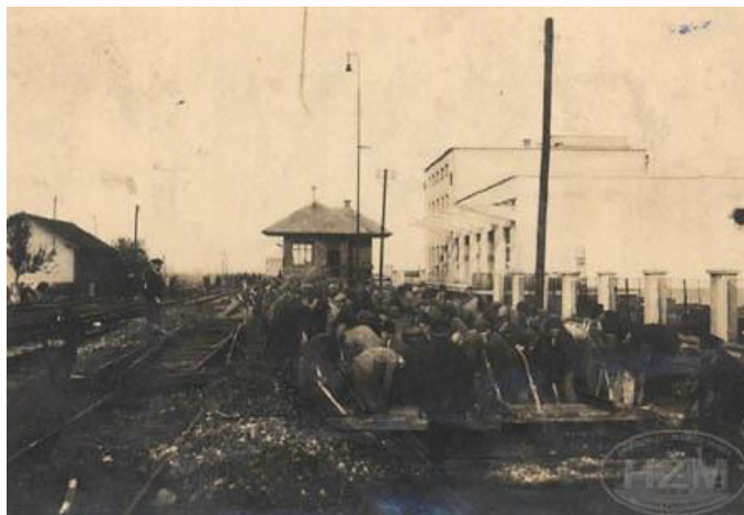
Slika 3. Ugradnja skretnice u kolodvoru Koprivnica
