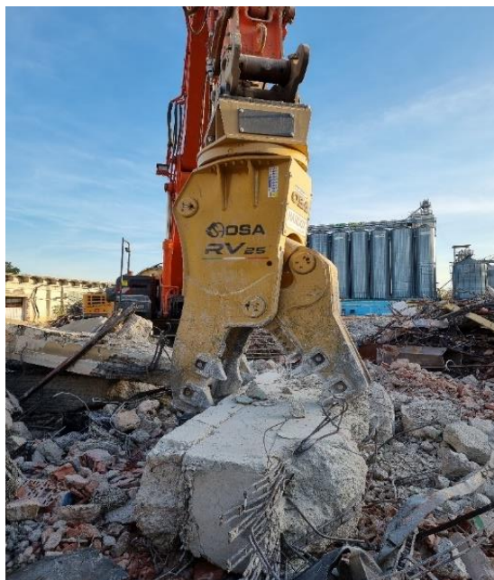
Slika 8. Hidraulične škare OSA [5]
