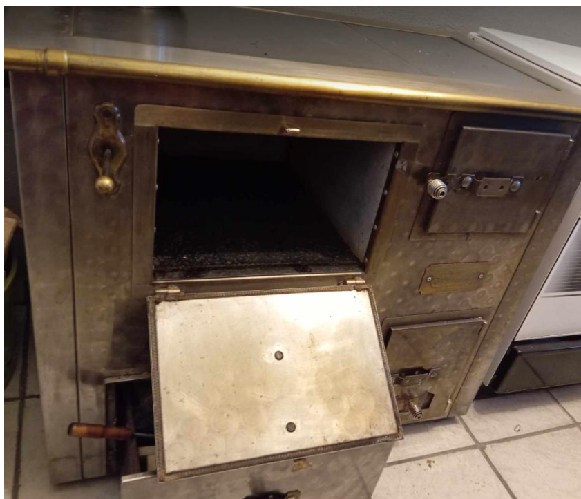
Slika 2. Peć na ogrjevna drva
