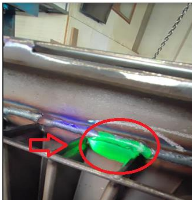
Slika 14. PT kontrola transformatorskog kotla
