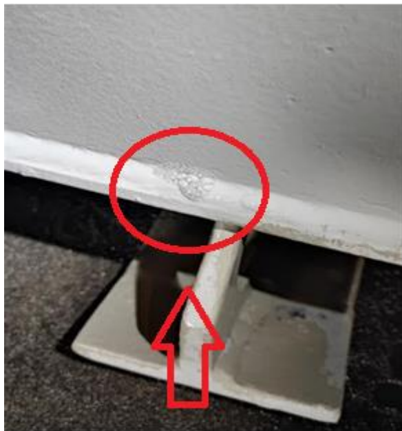
Slika 57. Drugo propuštanje kotla
