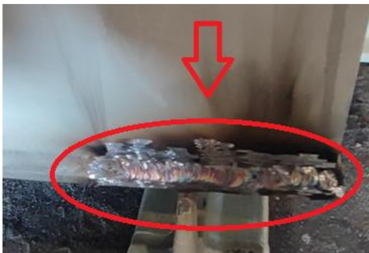
Slika 58. Popravak propuštanja TIG-om
