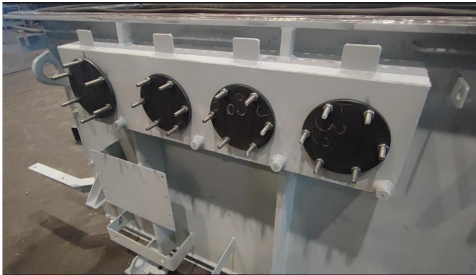
Slika 51. Zatvaranje rupa na kotlu
