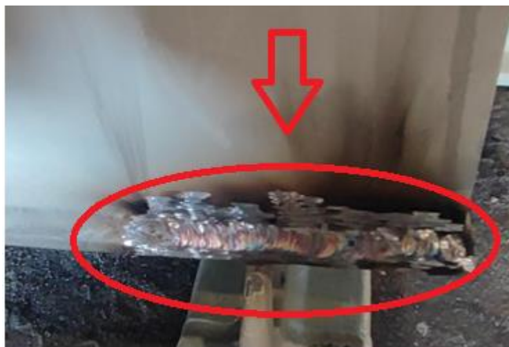
Slika 58. Popravak propuštanja TIG-om
