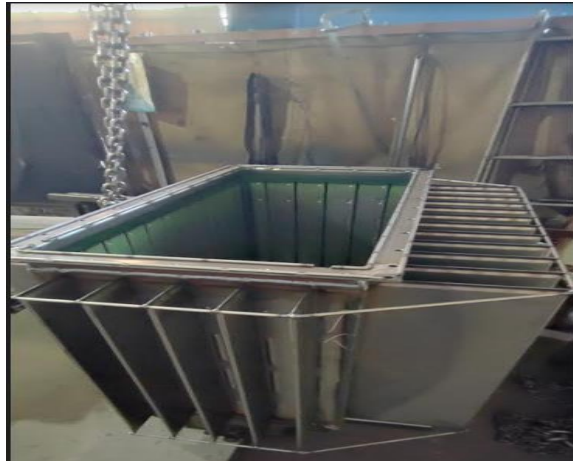
Slika 26. Mazanje kotla sa fluorescentnim penetrantom
