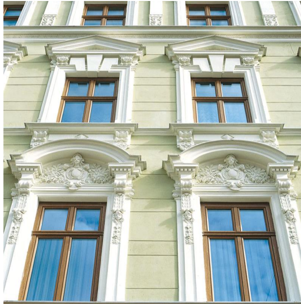
Slika 9. Vanjska drvena stolarija na objektu iz 1860. godine
