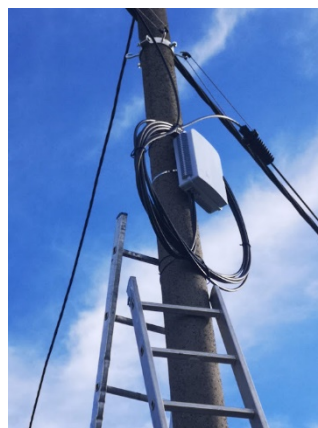
Slika 40. Montaža distribucijske kutije na stup (Izvor: autor)
