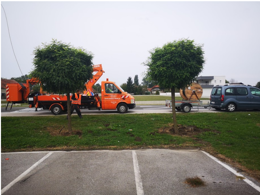
Slika 36. Povlačenje i montaža svjetlovodnog kabela (Izvor: autor)
