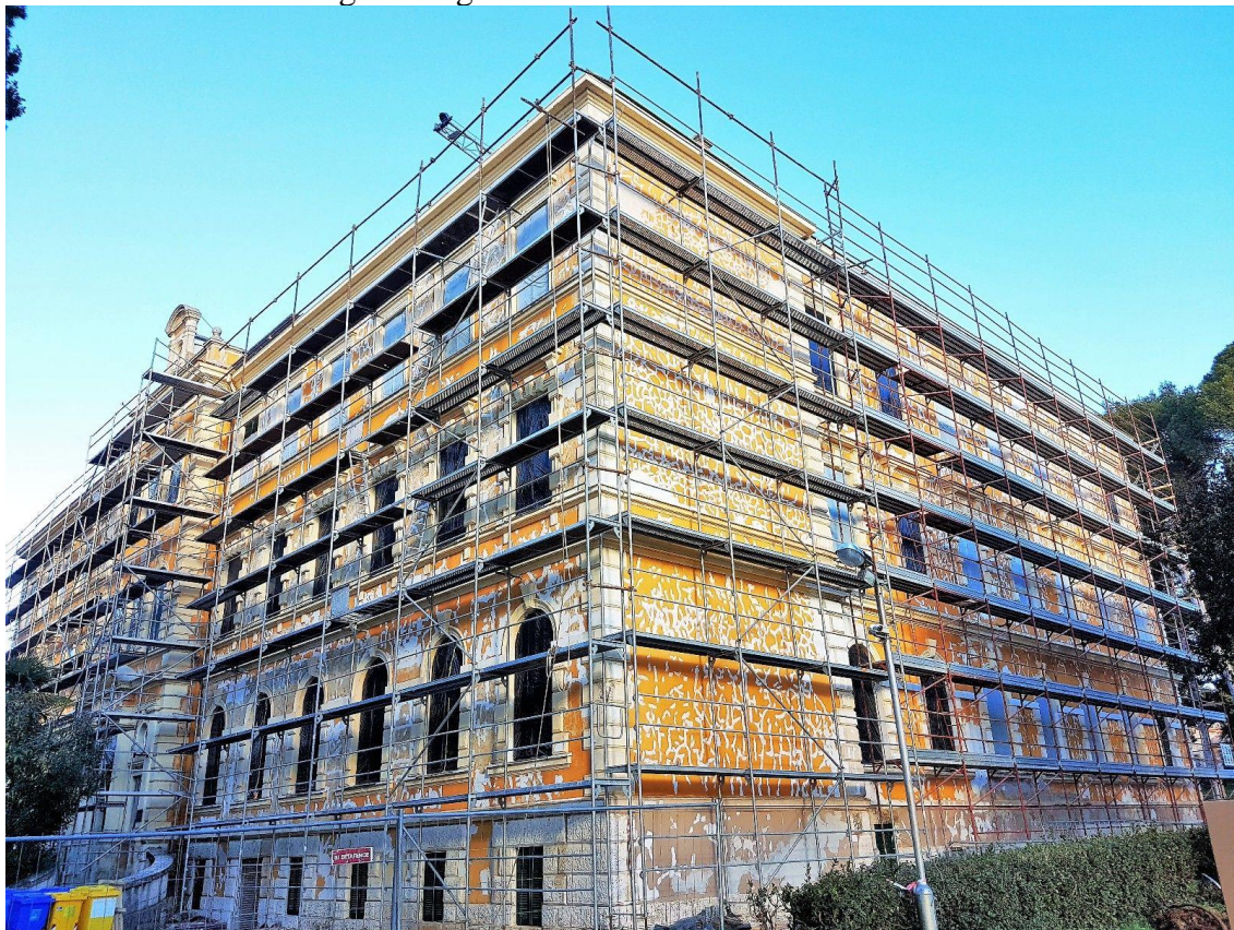
Slika 8. Obnova fasade glavne zgrade bolnice
