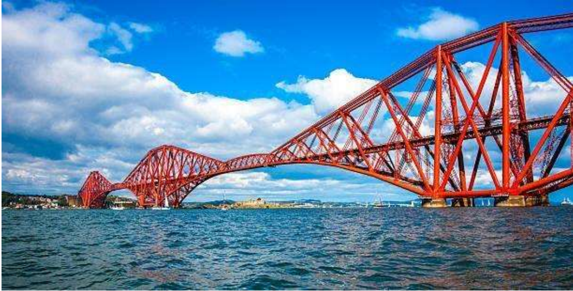
Slika 7. Konzolni most – Forth bridge u Škotskoj
