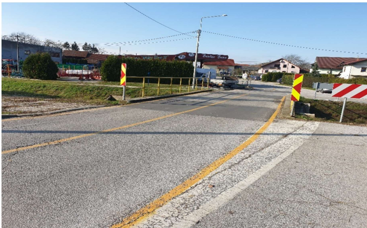
Slika 13. Postojeće stanje mosta – jugoistok
