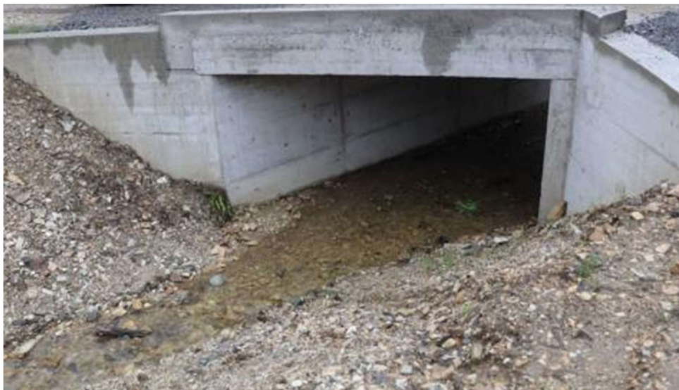
Slika 2. Primjer pločastog propusta
