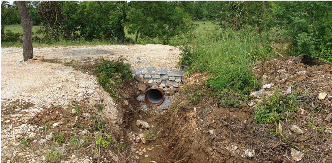
Slika 1. Primjer cijevnog propusta. Izvor: https://www.zuc-zadar.hr/sanacija-sustava-oborinske-odvodnje-u-brisevu/
