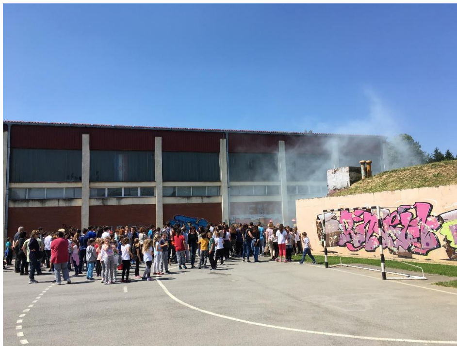
Slika 5. Vanjski izgled Školsko-sportske dvorane 1. osnovne škole Bjelovar
