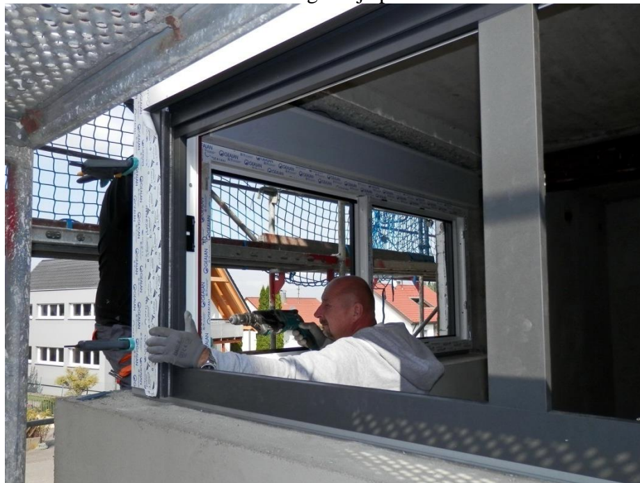
Slika 21. Ugradnja prozora
