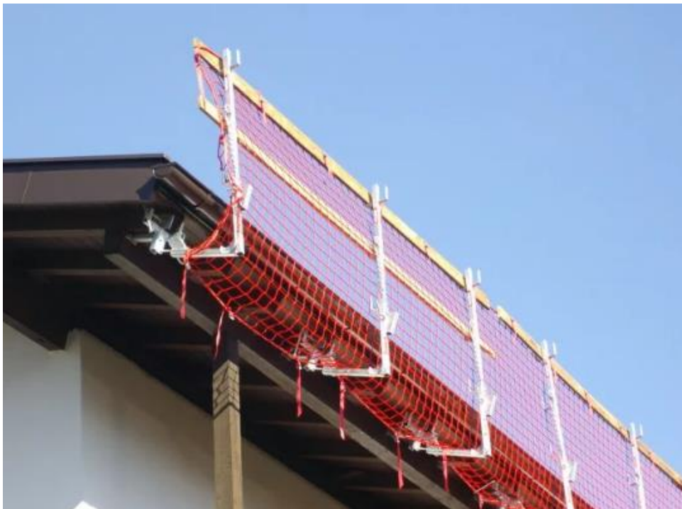
Slika 23. Zaštitna mreža za rad na kosim krovovima
