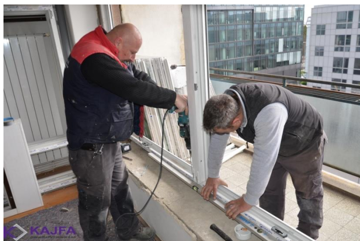
Slika 4. Ugradnja prozora
