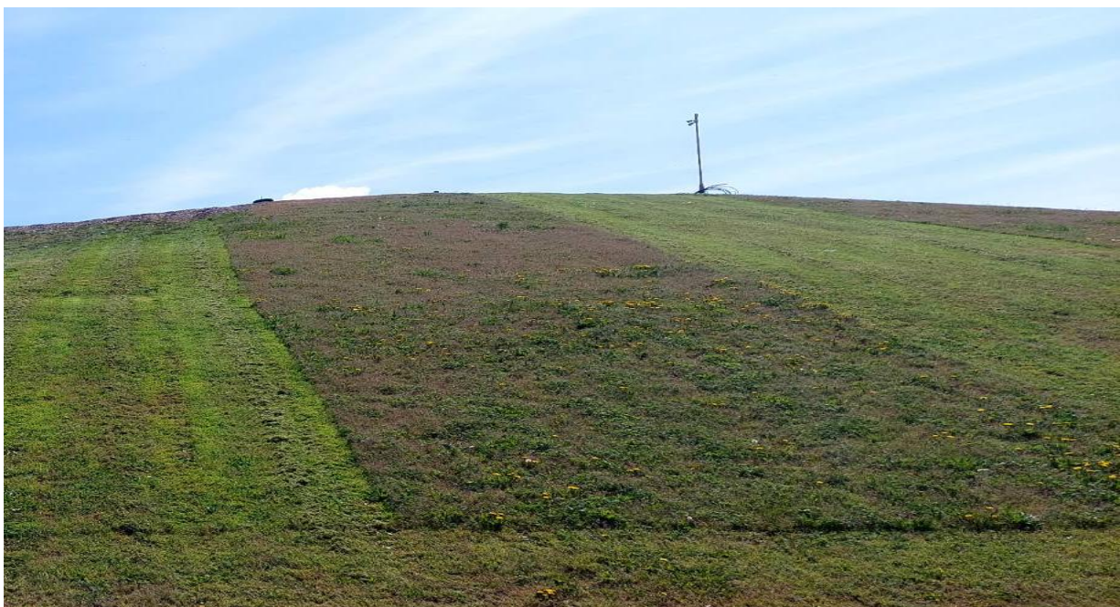
Slika 6. Aktivna odlagališna ploha s prekrivnim brtvenim sustavom
