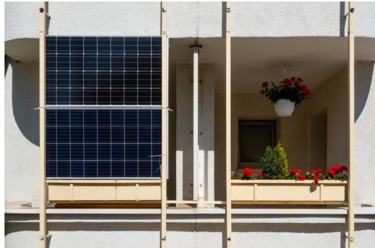
**Slika 27.** Solarni panel kao zasjenjivač balkona
