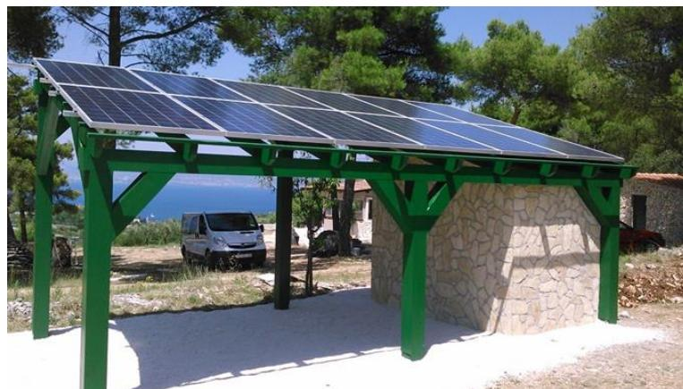
**Slika 31.** Solarni paneli kao samostalan pokrov
