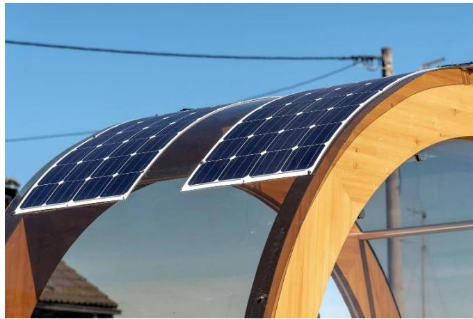
**Slika 33.** Prikaz zakriviljenih panela na neravnoj podlozi
