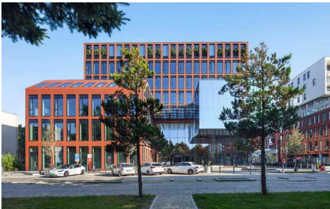
Slika 3. Primjer ostakljenja poslovne zgrade u Poljskoj [3]
