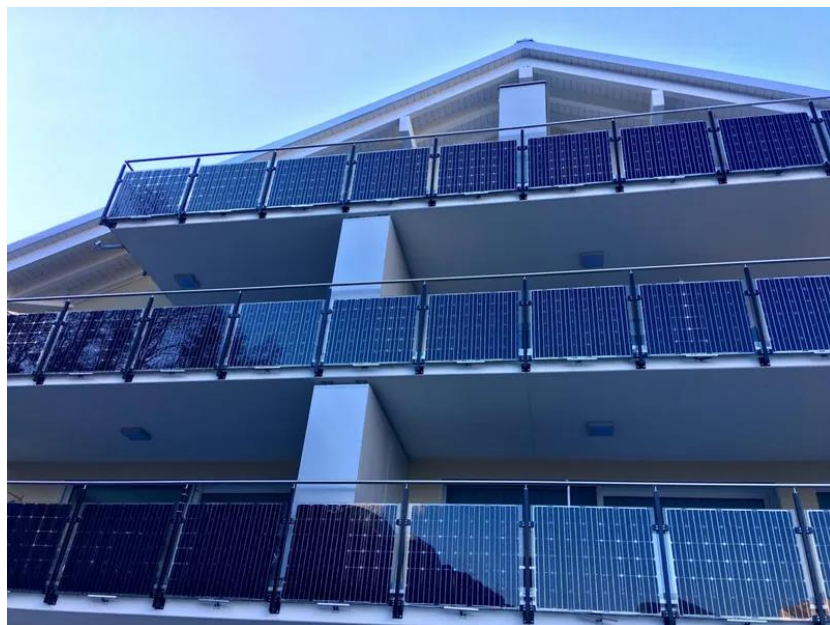
Slika 35. Iskorištavanje solarnih panela kao balkonskih ograda
