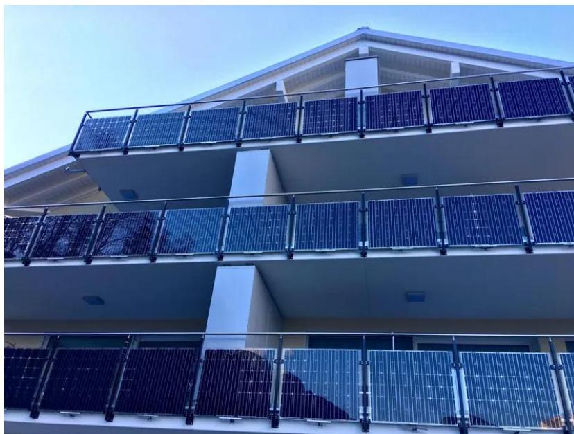
**Slika 35.** Iskorištavanje solarnih panela kao balkonskih ograda
