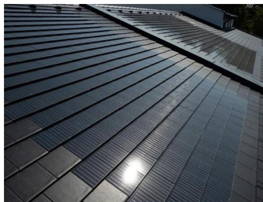
**Slika 37.** Limeni krov s ugrađenim solarnim panelima
