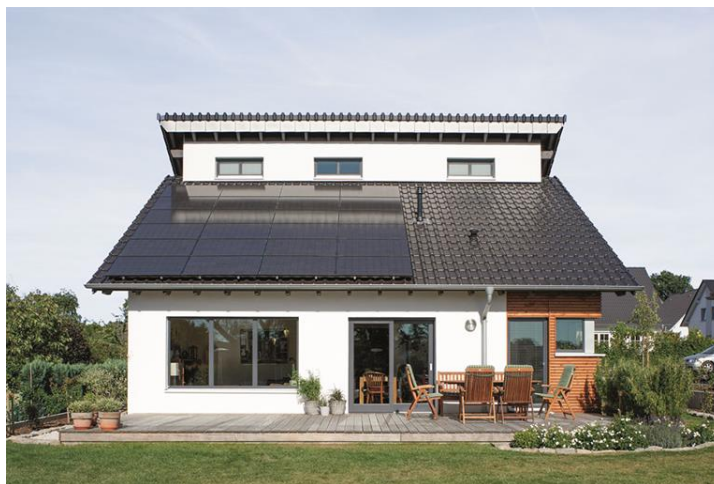
Slika 38. Solarni paneli koji su dobro uklopljeni u pokrov krova
