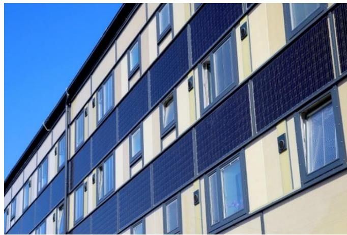
**Slika 34.** Solarni paneli na stambenoj zgradi uklopljeni u fasadu
