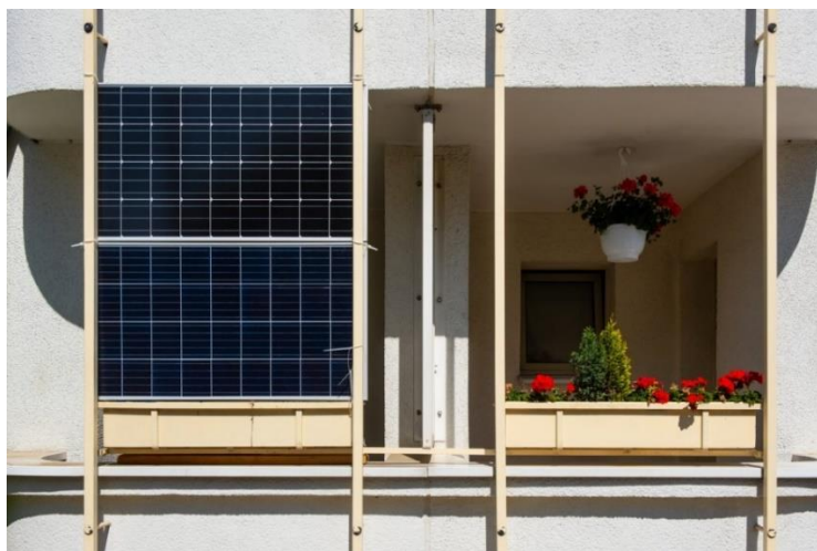
Slika 27. Solarni panel kao zasjenjivač balkona
