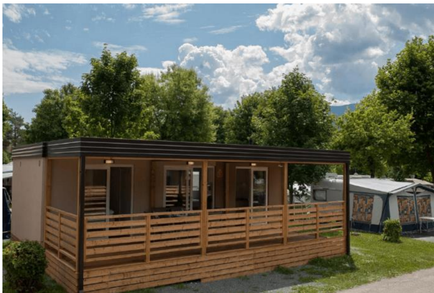
Slika 9. Pogled na mobilne kućice
