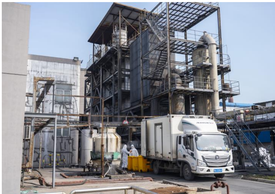
Slika 6. Postojeći objekt za obradu industrijskog opasnog otpada prenamijenjen za obradu medicinskog otpada u Wuhanu
