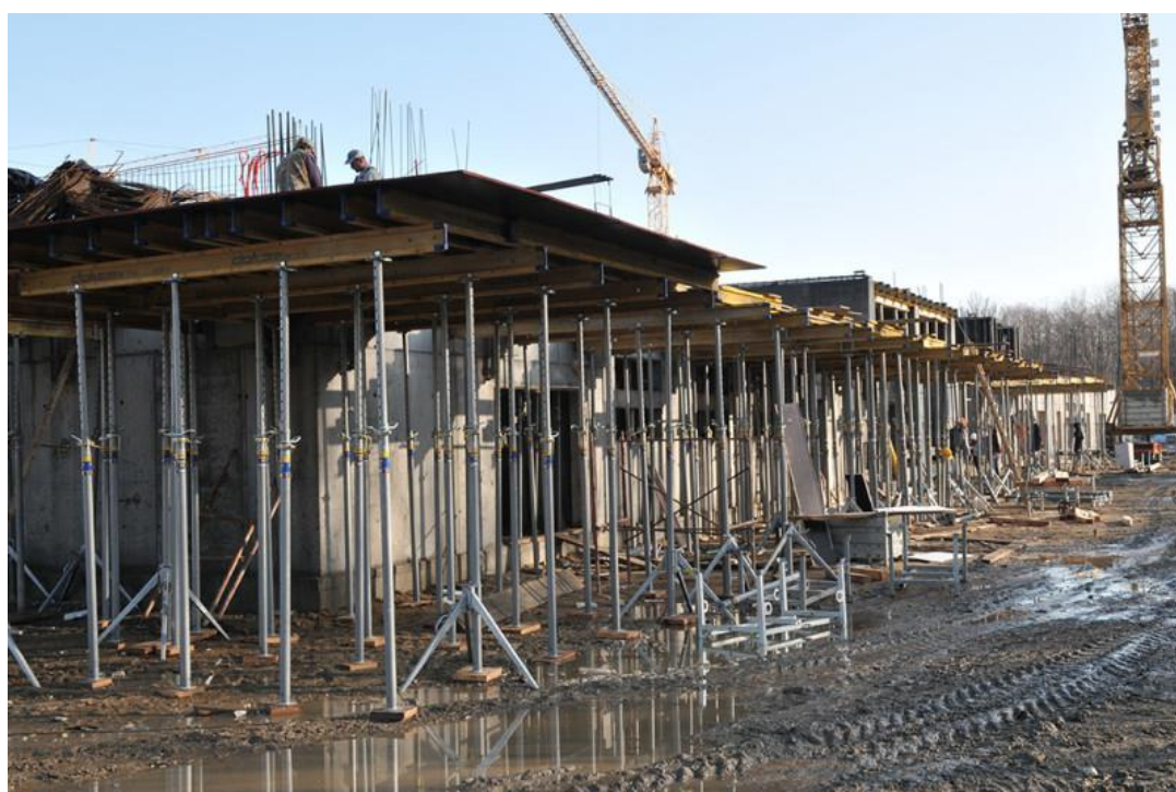
Slika 5 Izgradnja Arene Varaždin
