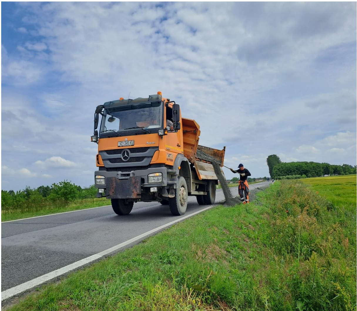
Slika 18. Transport kamenog materijala za ugradnju na bankine
