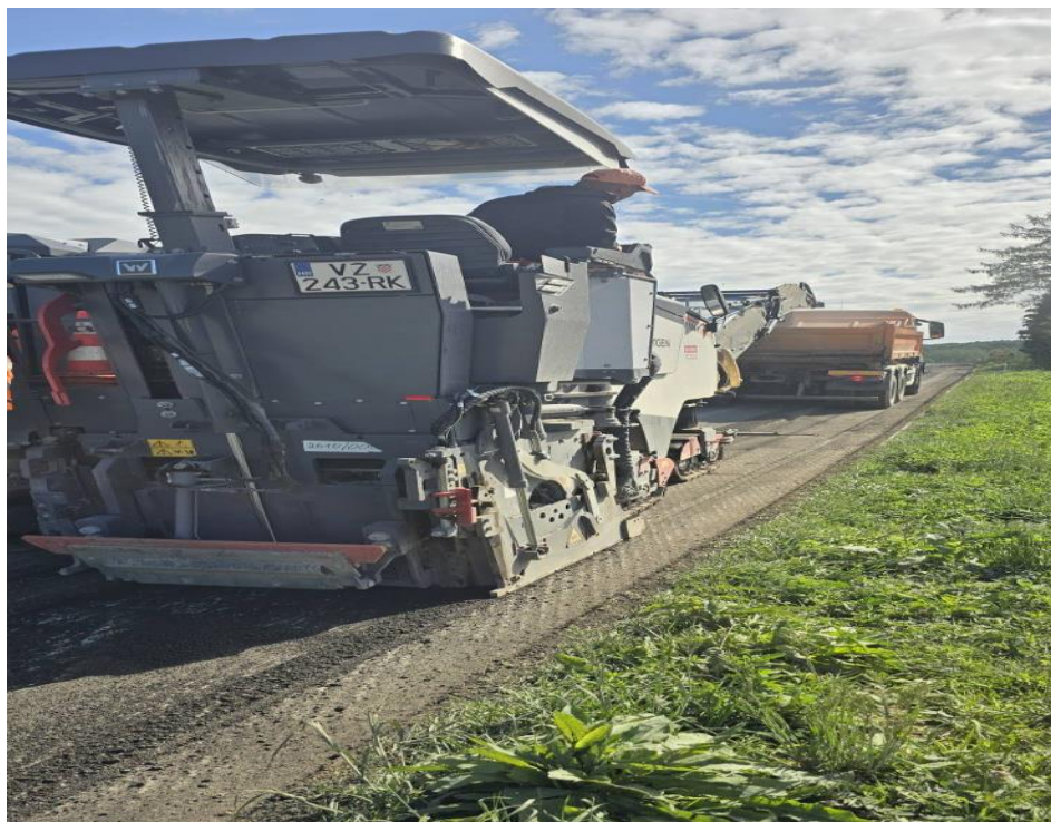
Slika 23. Glodanje asfalta frezom
