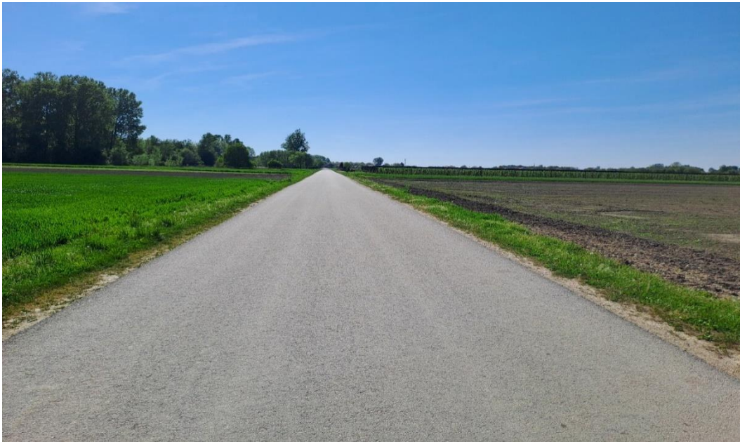
Slika 13. Lokalna cesta LC20086 Draškovec- Čukovec
