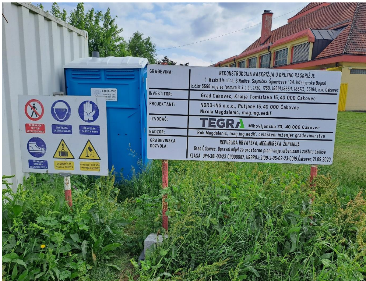
Slika 20. Tabla gradilišta sa tablom zaštite na radu
