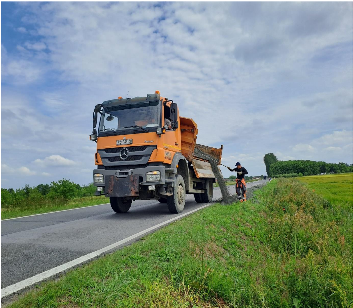
Slika 18. Transport kamenog materijala za ugradnju na bankine
