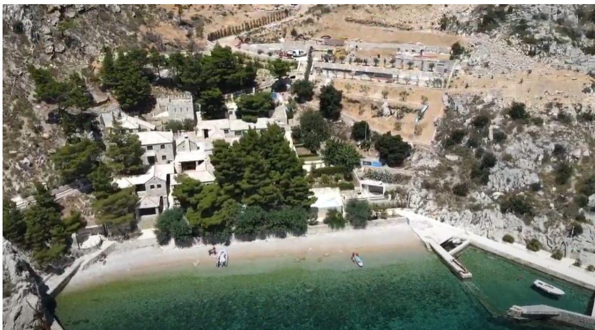
Slika 2. Bespravna gradnja resorta u uvali Vruja
