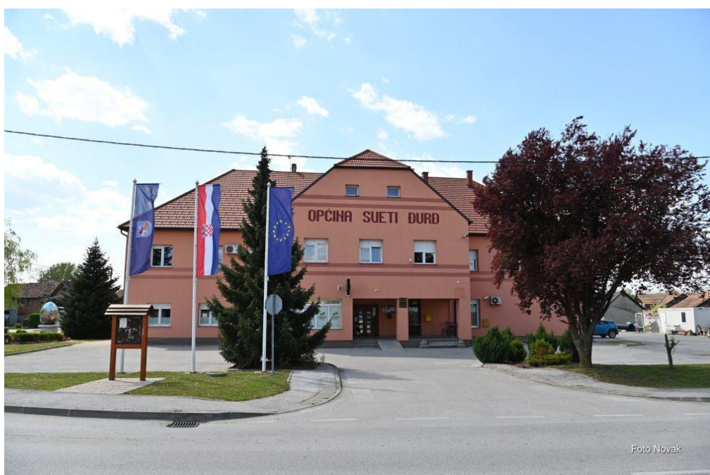
Slika 1. Zgrada Općine Sveti Đurđ
