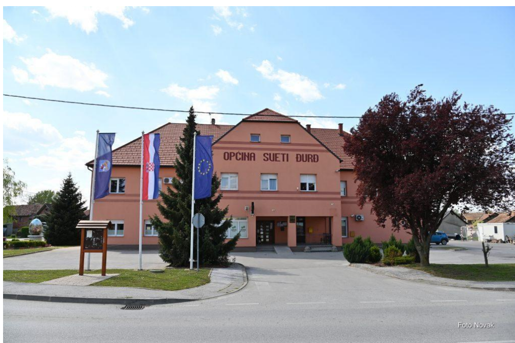
Slika 1. Zgrada Općine Sveti Đurđ
