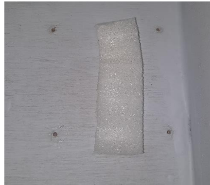
Slika 27. Rupe za pričvršćenje pumpi
