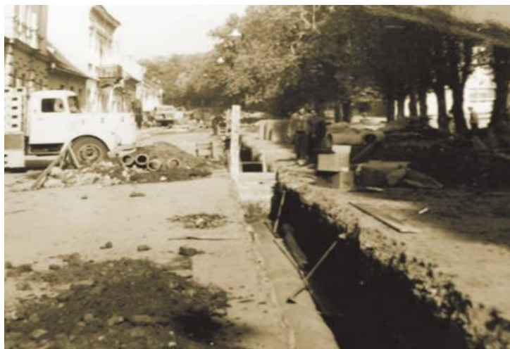
Slika 9. Detalj gradnje vodoopskrbne mreže 1965.
