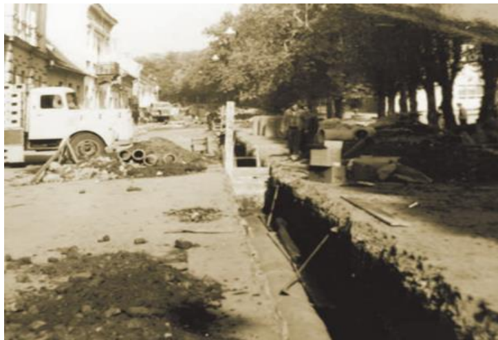
Slika 9. Detalj gradnje vodoopskrbne mreže 1965.
