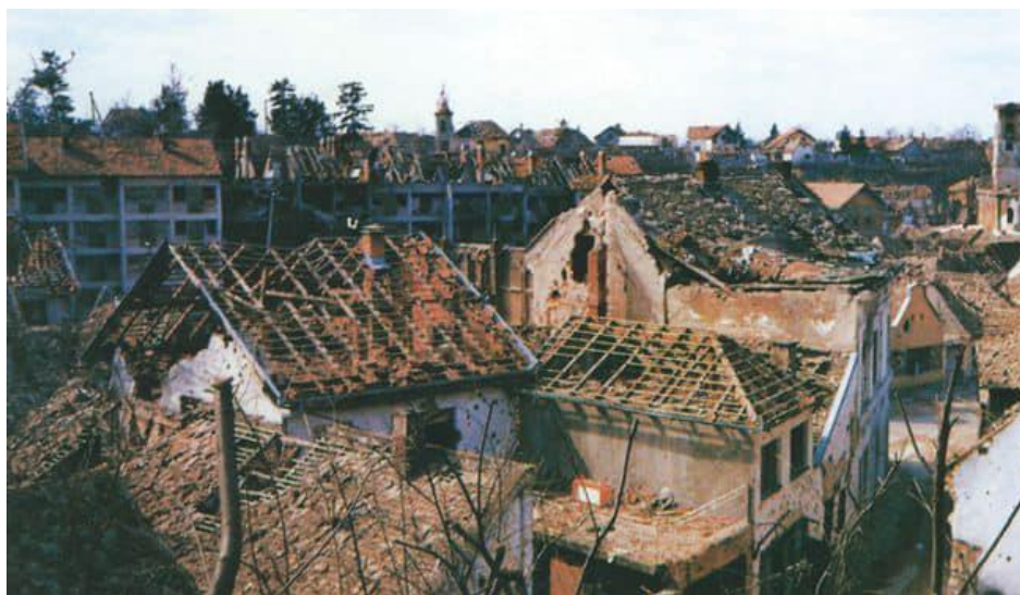
Slika 28. Grad Vukovar u ruševinama tijekom Domovinskog rata
