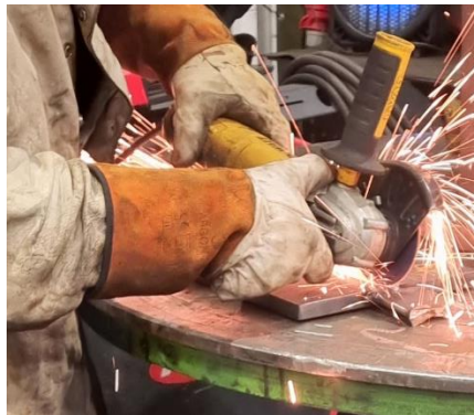
Slika 17. Čišćenje nečistoća u zavaru sa kutnom brusilicom
