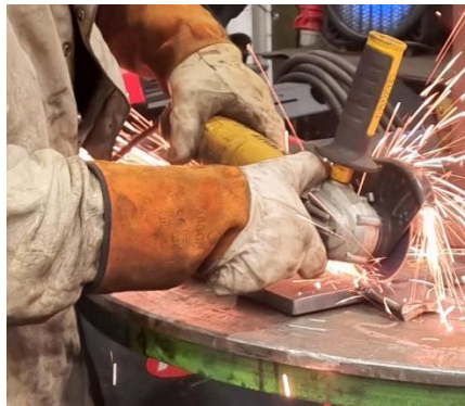
Slika 17. Čišćenje nečistoća u zavaru sa kutnom brusilicom
