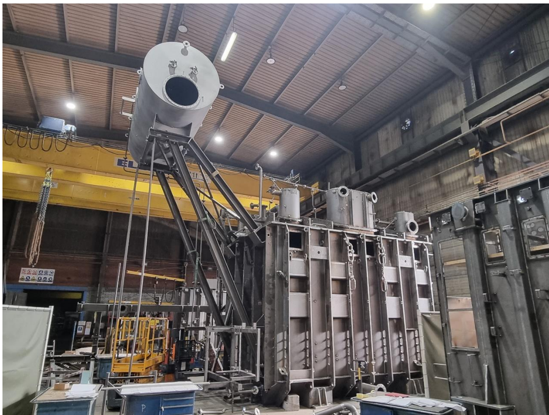
Slika 1. Probna montaža glavnih i osnovnih komponenti trafokotla
