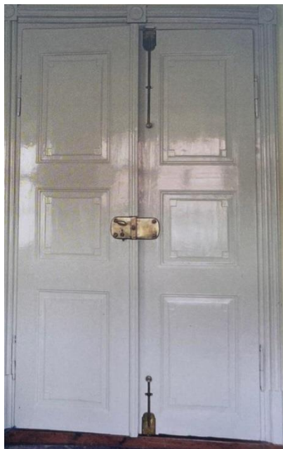
Fotografija 26. Drvena vrata s mehanizmom za zaključavanje
