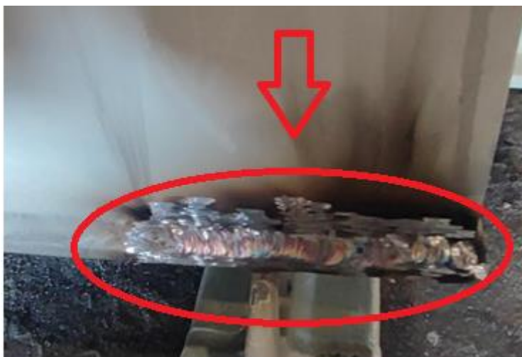
Slika 58. Popravak propuštanja TIG-om
