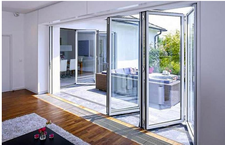
Slika 17. Primjer aluminijske harmo-stijene
