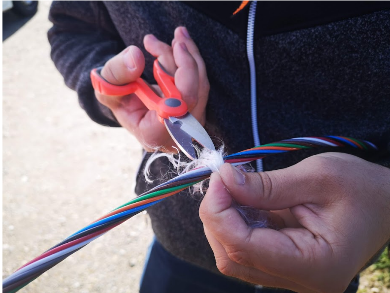
Slika 28. Prikaz tuba u kojima se nalaze svjetlovodne niti ( Izvor: autor)
