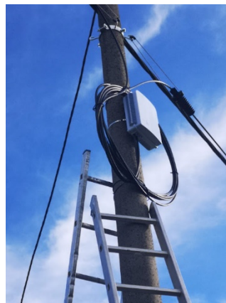
Slika 40. Montaža distribucijske kutije na stup (Izvor: autor)
