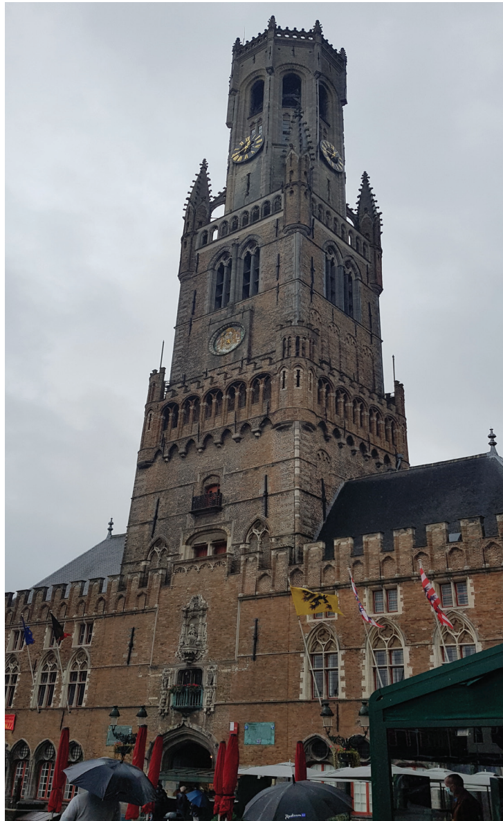
Slika 3. Brugge — toranj Belfort
