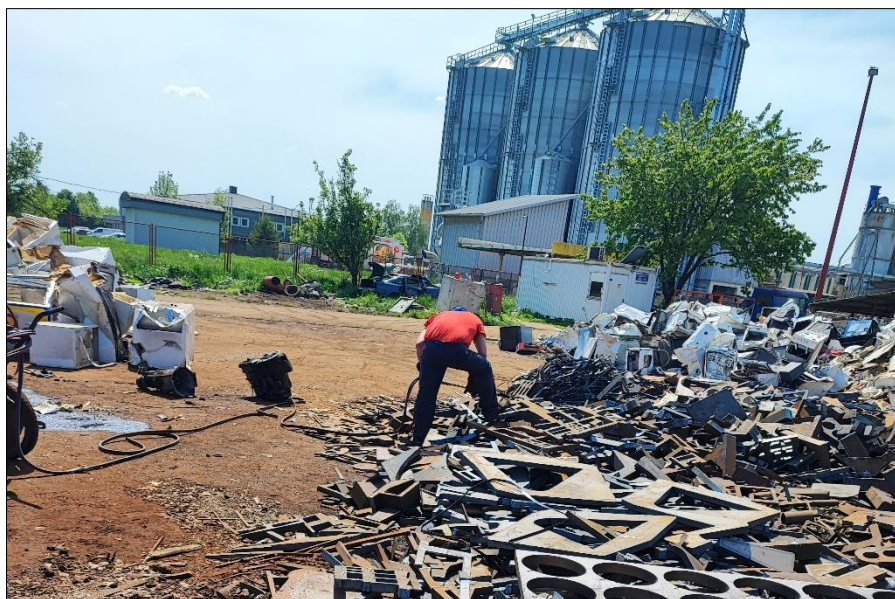
Slika 23. Mehanička obrada neopasnog metalnog otpada autogenim rezanjem
