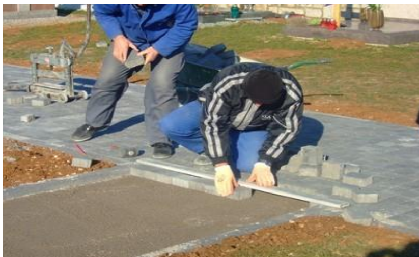
Slika 10. Primjer postavljanja opločnika (Izvor: https://oblak-beton.hr/tehnicka_pomoc/upute_za_polaganje_oplocnika/ )
