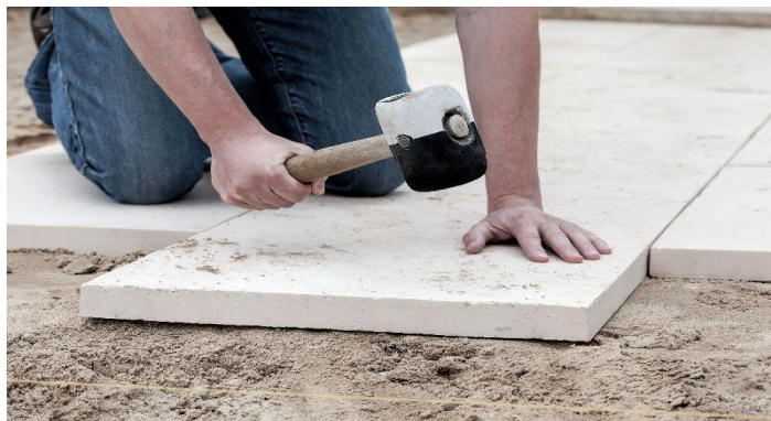
Slika 11. Primjer postavljanja betonskih ploča (Izvor: https://www.emajstor.hr/cijene/tlakovanje )
