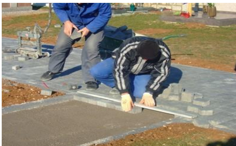
Slika 10. Primjer postavljanja opločnika (Izvor: https://oblak-beton.hr/tehnicka_pomoc/upute_za_polaganje_oplocnika/ )
