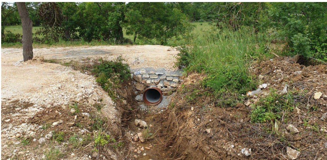
Slika 1. Primjer cijevnog propusta. Izvor: https://www.zuc-zadar.hr/sanacija-sustava-oborinske-odvodnje-u-brisevu/
