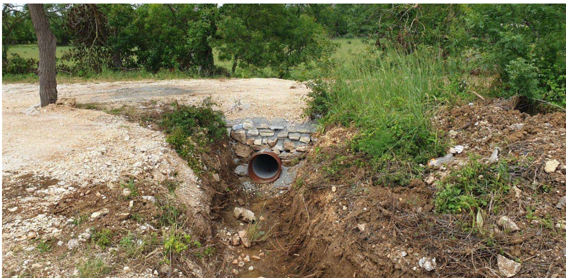
Slika 1. Primjer cijevnog propusta. Izvor: https://www.zuc-zadar.hr/sanacija-sustava-oborinske-odvodnje-u-brisevu/
