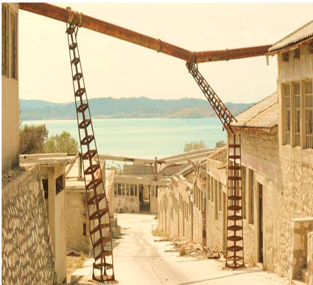
Slika 17. Devastirani objekti na Golom otoku
