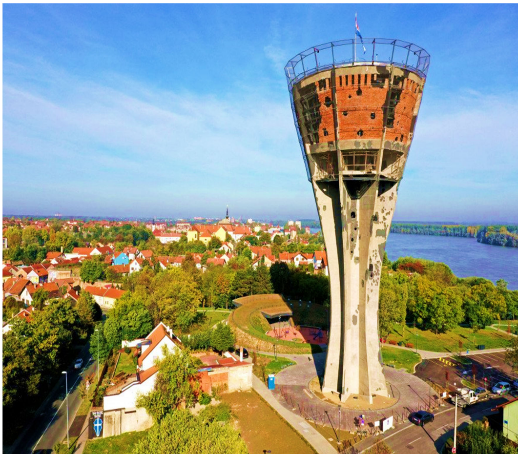
Slika 11. Vukovarski vodotoranj – simbol stradanja u Domovinskom ratu
