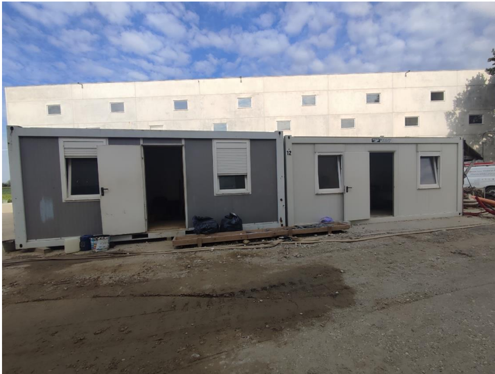
Slika 9. Kontejneri na gradilištu
