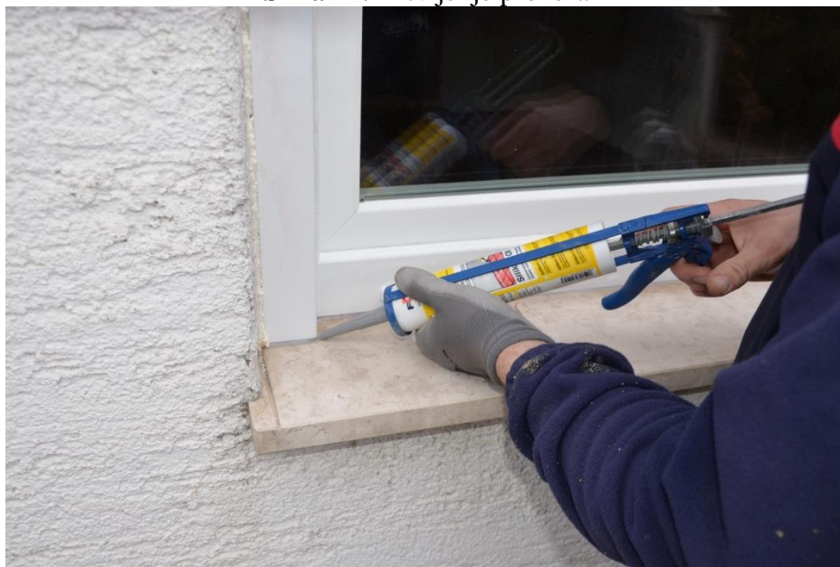
Slika 22. Brtvljenje prozora
