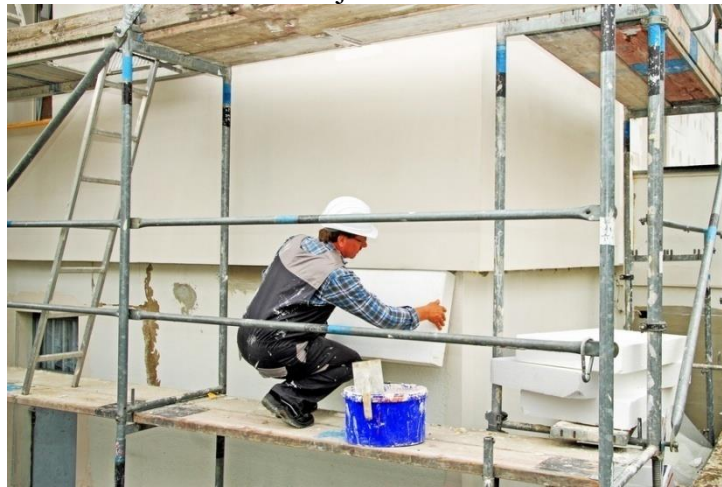
Slika 3. Izvođenje fasaderskih radova
