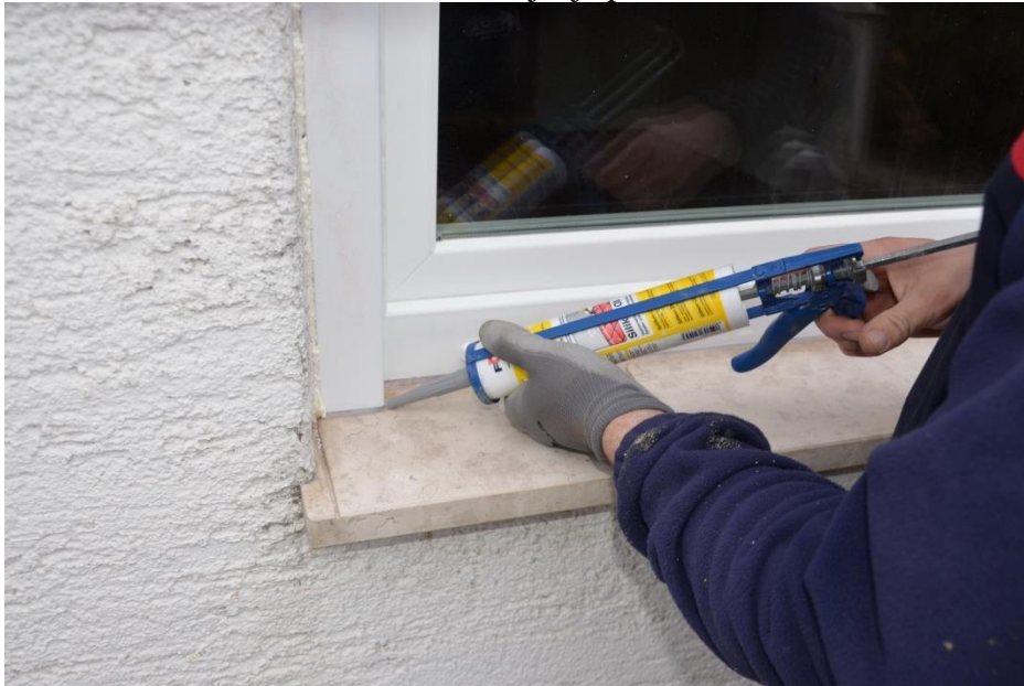
Slika 22. Brtvljenje prozora
