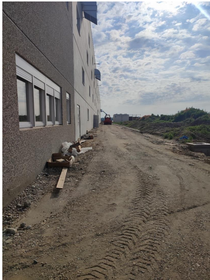
Slika 14. Privremena prometnica na gradilištu
