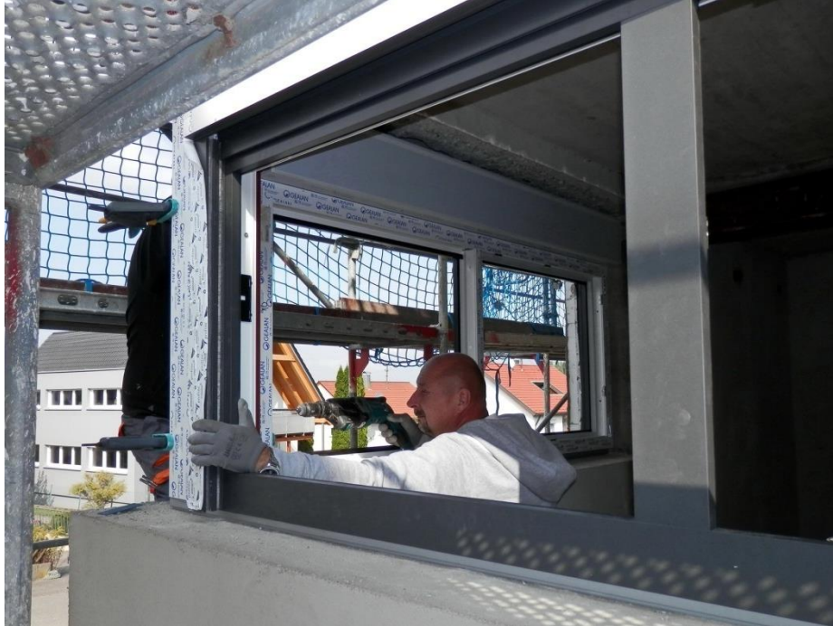
Slika 21. Ugradnja prozora
