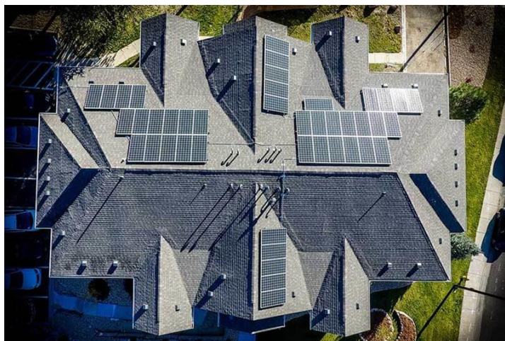
Slika 39. Postavljeni solarni paneli prate razvedenost i orijentaciju krova
