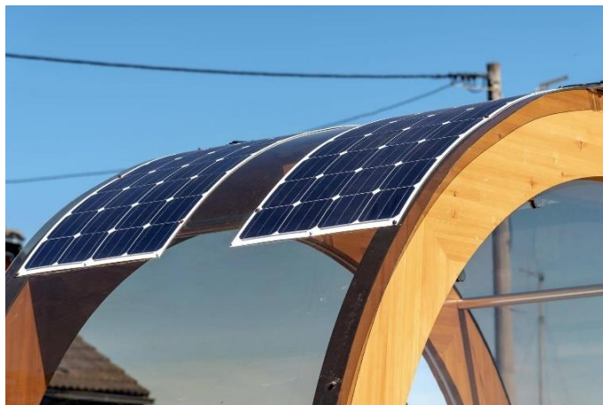
Slika 33. Prikaz zakrivljenih panela na neravnoj podlozi
