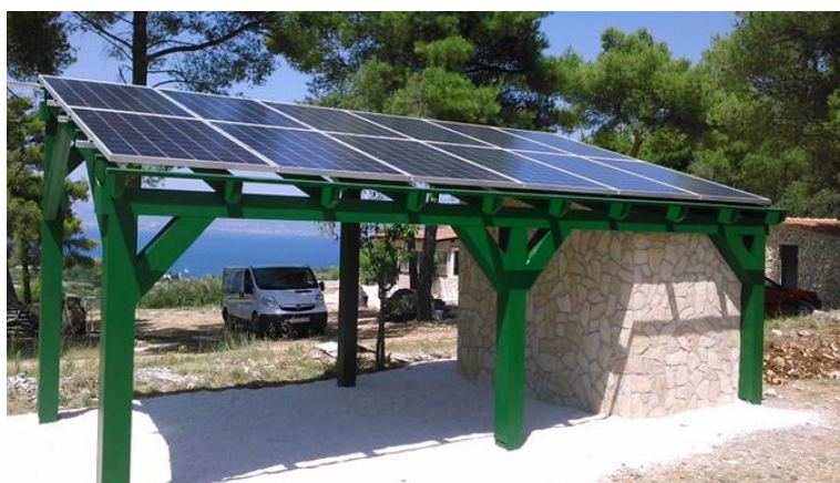
Slika 31. Solarni paneli kao samostalan pokrov
