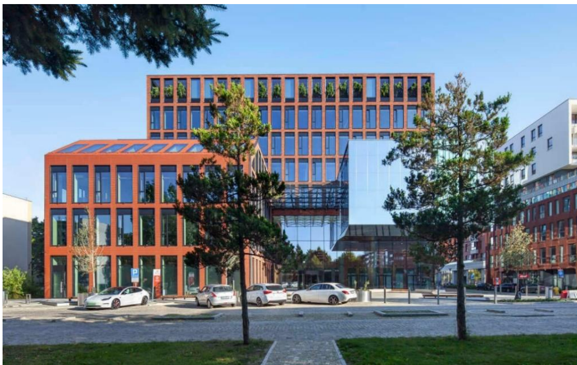
Slika 3. Primjer ostakljenja poslovne zgrade u Poljskoj [3]
