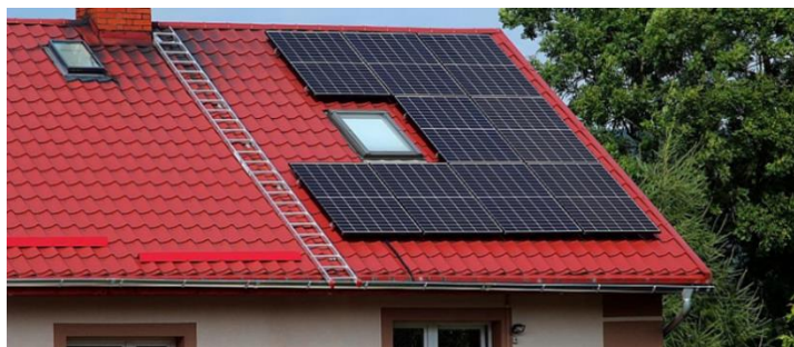
Slika 41. Loša uklopljenost boje panela s bojom pokrova
