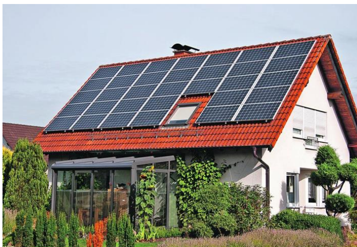
Slika 40. Primjer krova preopterećenog panelima
