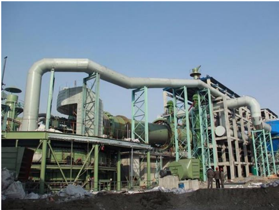
Slika 12. Peć prilagođena za spaljivanje medicinskog otpada
