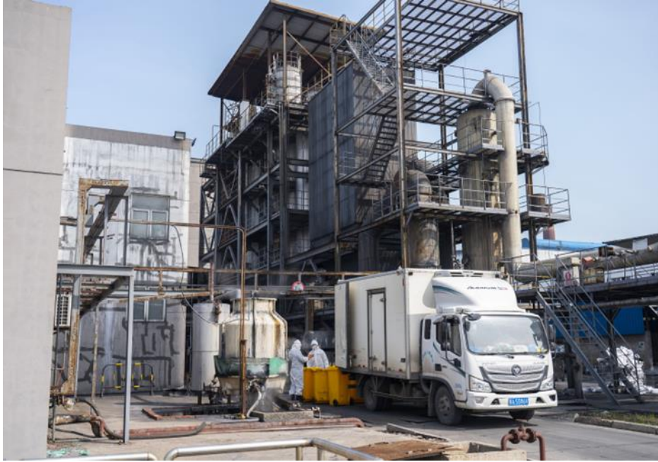
Slika 6. Postojeći objekt za obradu industrijskog opasnog otpada prenamijenjen za obradu medicinskog otpada u Wuhanu
