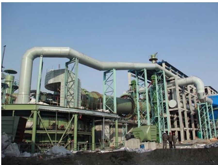
Slika 12. Peć prilagođena za spaljivanje medicinskog otpada
