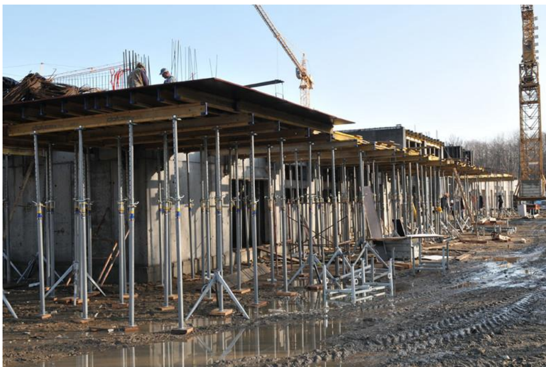
Slika 5 Izgradnja Arene Varaždin
