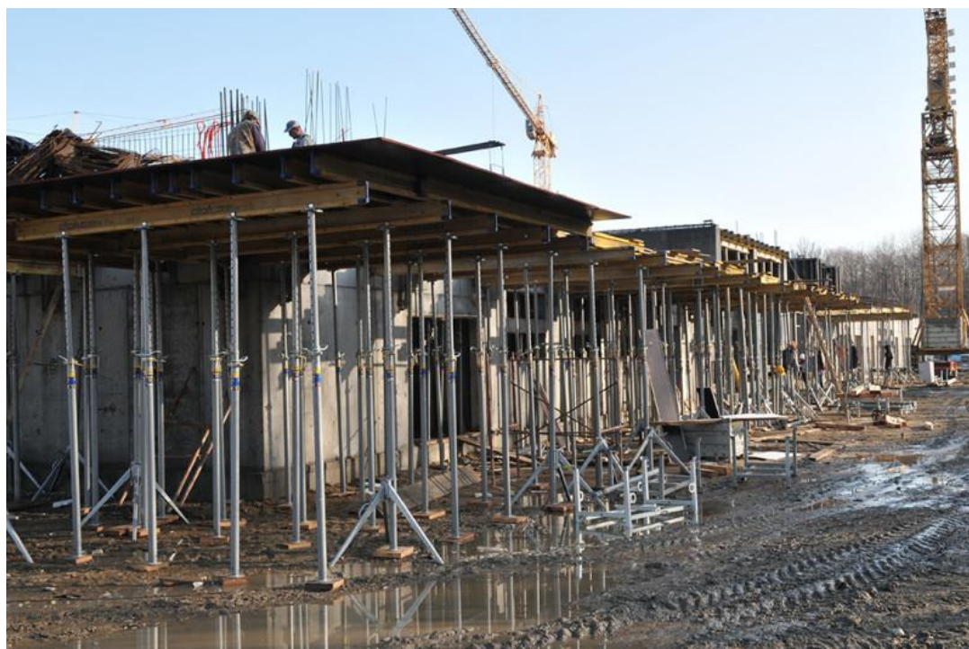
Slika 5 Izgradnja Arene Varaždin
