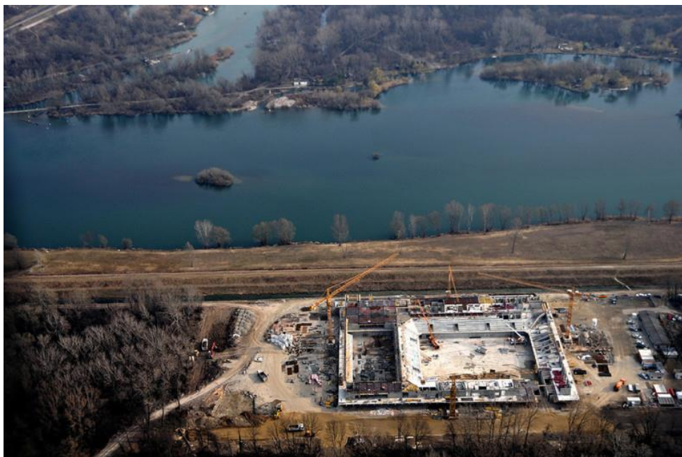
Slika 4 Izgradnja Arene Varaždin
